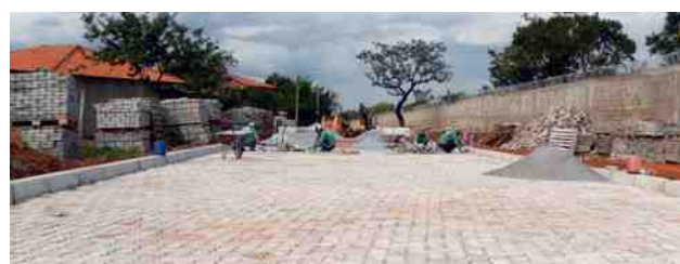
Rua do Lazer em 2012, última rua do RK pavimentada. Trabalho de terraplanagem e assentamento de bloquetes em 2014
