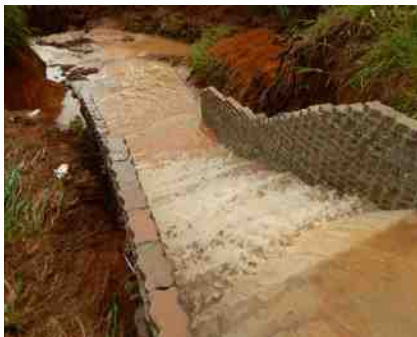
Foram construídos na área externa bolsões, curvas de nível e escadas de amortecimento para amenizar os danos ambientais
