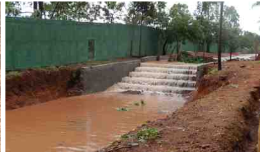
Construção de escadas, canaletas e bolsões na área interna do RK para amenizar os estragos causados pelas águas que correm superficialmente
