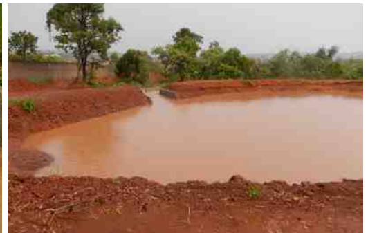
Foram construídos na área externa bolsões, curvas de nível e escadas de amortecimento para amenizar os danos ambientais
