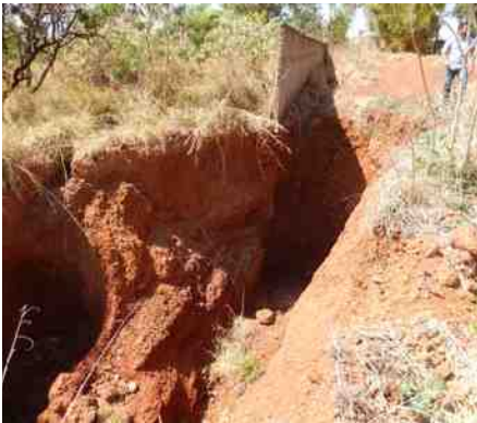
Erosões e voçorocas nas chácaras vizinhas causadas pelas águas pluviais provenientes do RK que ainda não estão canalizadas
